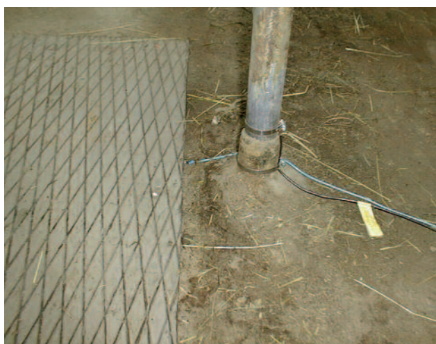
Figure 1 : La mise en place d'un enregistreur permanent est une technique lourde mais très performante : la figure montre les connexions à réaliser (Cliché F. Gallouin).
